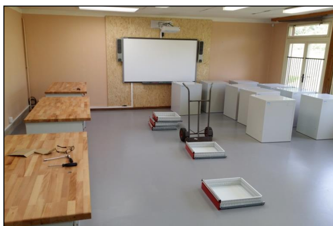
Fotografie Z PRŮBĚHU MODERNIZACE
